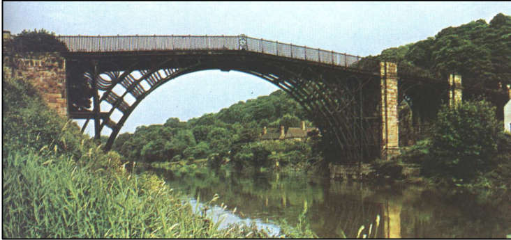
11. Puente de hierro de Coalbrookdale. 1777.
